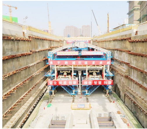
装配式车站施工中。
