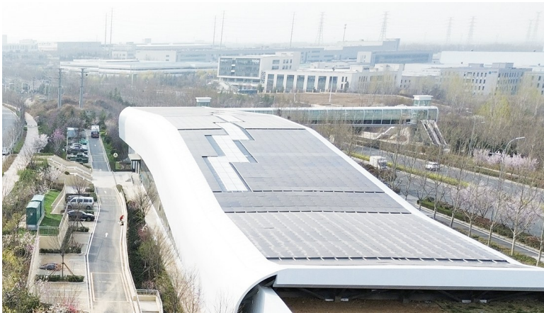
横云山路站光伏系统。
