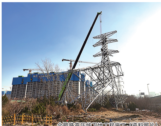
合肥路高压线下地工程施工。（资料照片）
