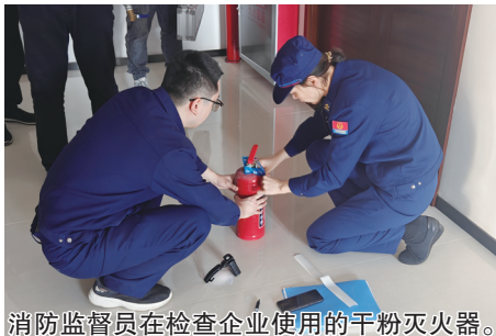
消防监督员在检查企业使用的干粉灭火器。
