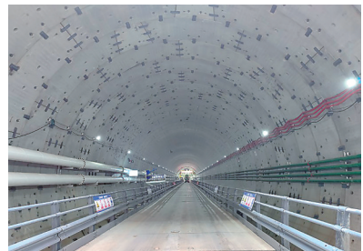
“海天号”盾构机已掘进至海底40米。
