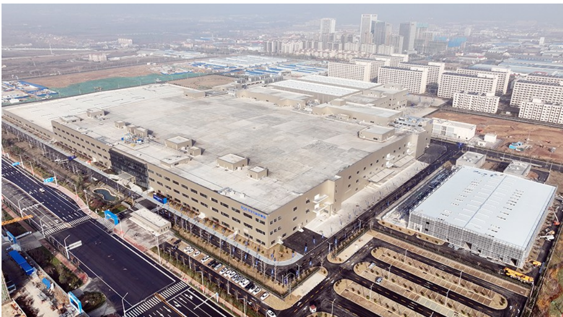
青岛京东方光电科技有限公司。
