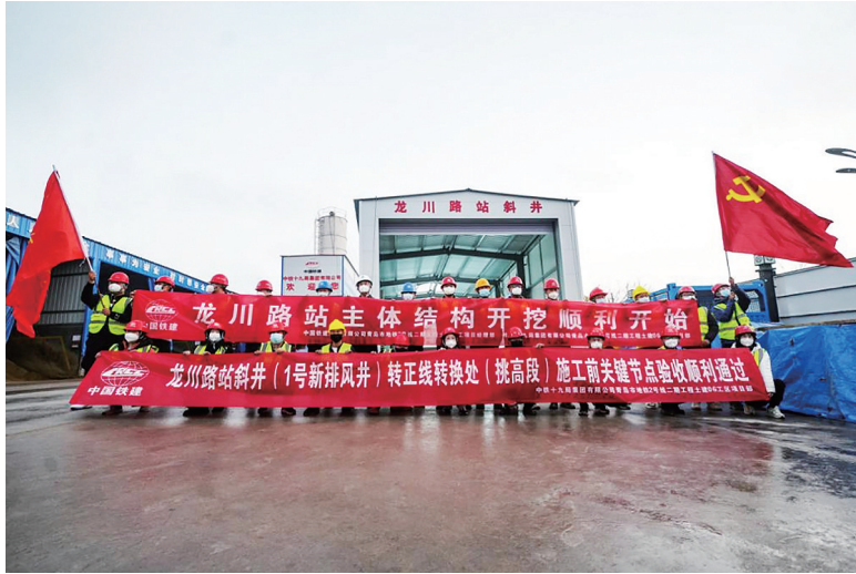
2号线二期龙川路站挖下“第一铲”。
