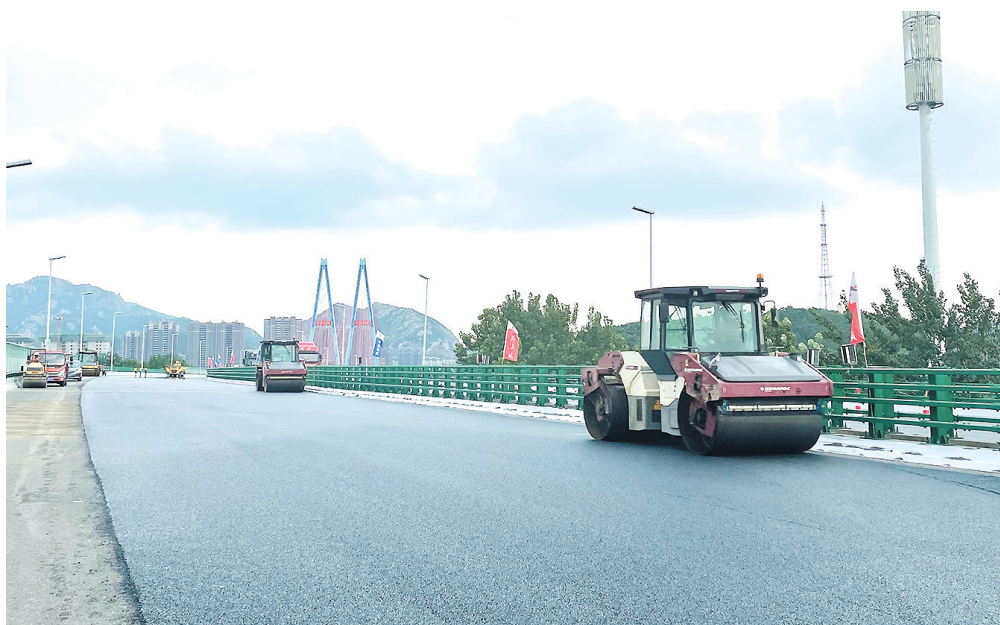
青银高速丹山特大桥工程提前完工。
