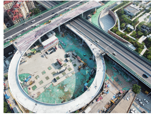
■项目全面转入桥面铺装和附属设施施工阶段。
