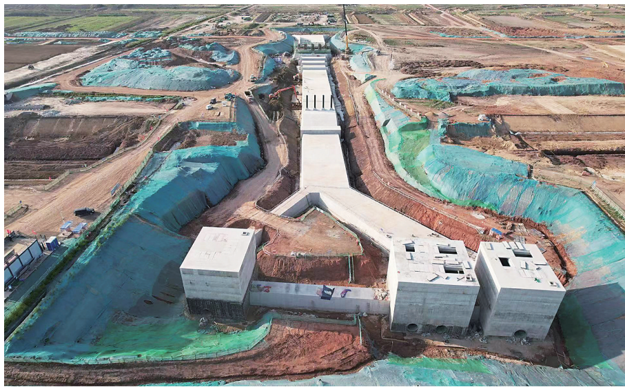
■官路水库青岛出库泵站施工现场。
