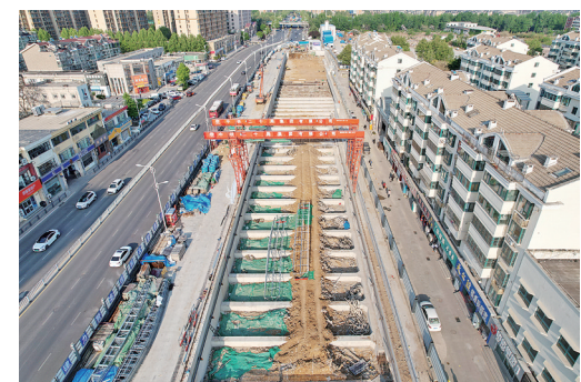
地铁2号线二期工程下王埠站施工现场。
