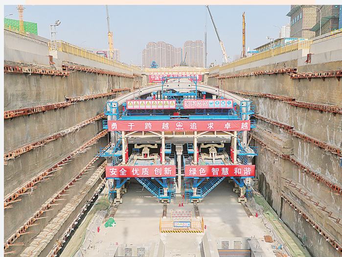
正在施工的装配式车站。
