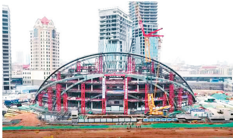
■邮轮港区“世界之眼”项目钢拱结构合龙封顶。
