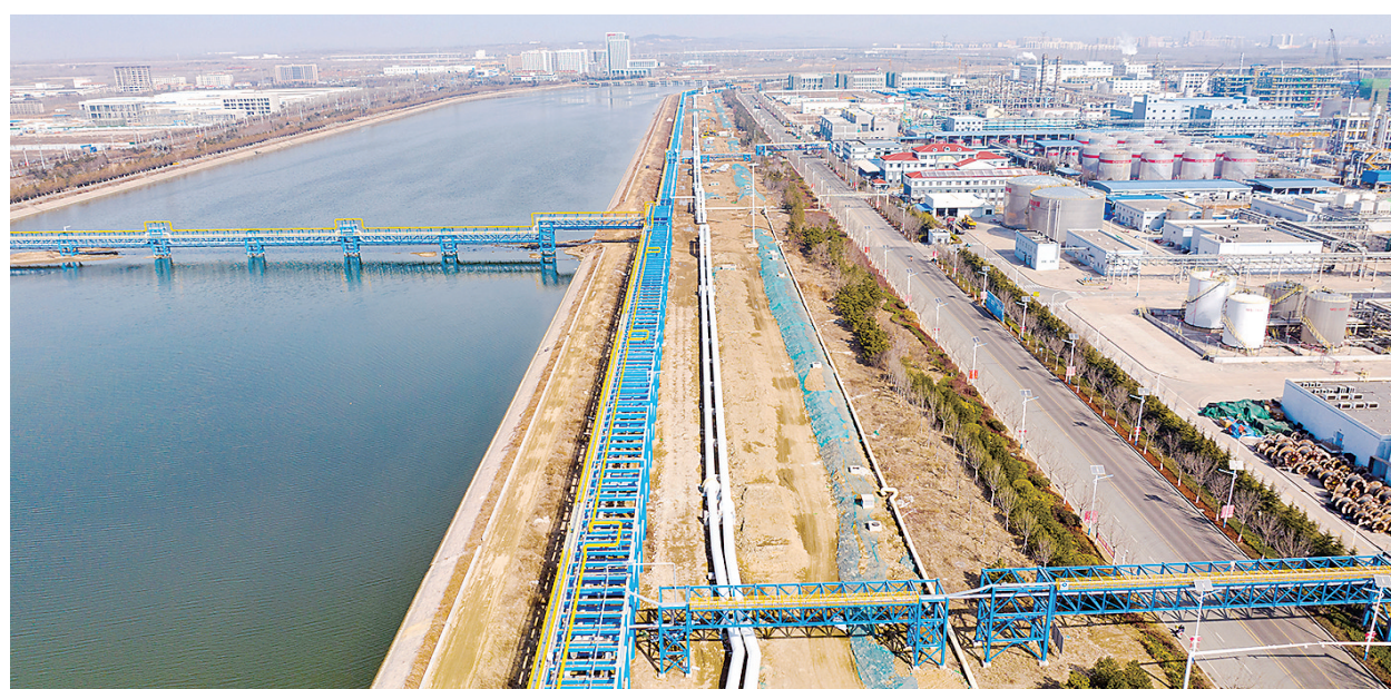
青钢余热综合利用项目供热管线。集团整合西海岸新区大型电厂余热和工业余热，依托华能热力出线和大唐热力出线两条供热主轴线，积极接入青钢余热、静脉产业园余热等工业余热，谋划预留海湾化学、中科成污水等清洁能源供热，构建起“一网多源”绿色供热新体系。
