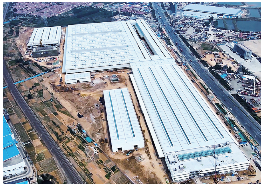
■潍柴(青岛)智慧重工智造中心项目完成所有钢结构围护安装,进入设备基础施工阶段。
