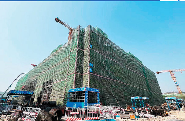
■建设中的青岛虚拟现实整机和光学模组项目。
