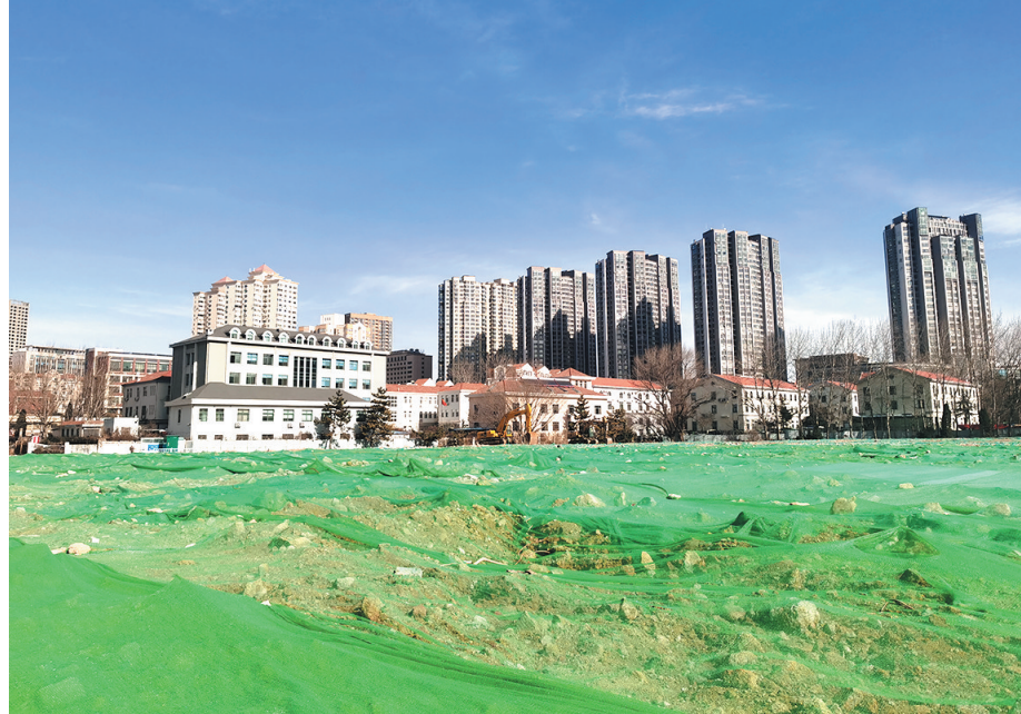
■物美城市更新项目地块已经完成土地平整。余瑞新 摄
