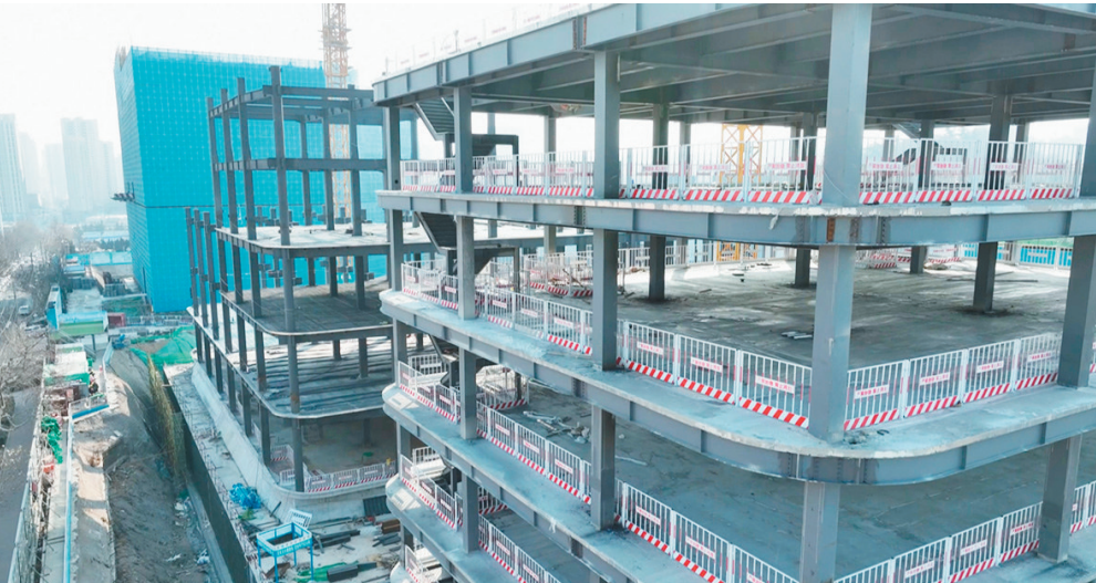
■市北都市科技园项目1号楼、3号楼已主体结构封顶。
