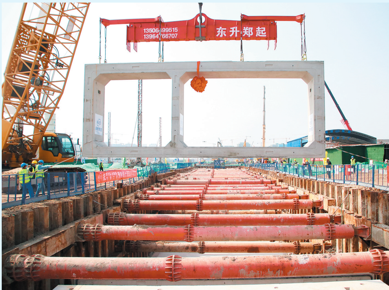
■今年4月份，唐河路-安顺路打通工程首节预制地下综合管廊安装完成。王冰洁 摄
