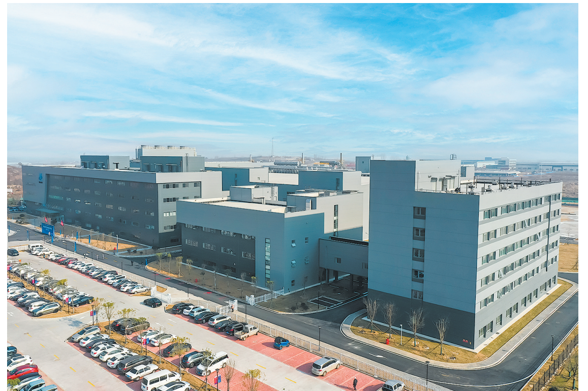
■青岛市集成电路产业园内的新核心高端封测项目。
