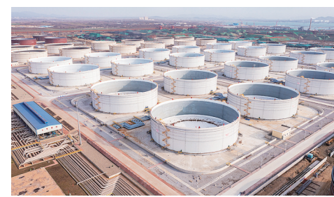
24座10万立方米浮顶油罐拔地而起。
